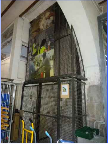
MUNTATGE DE NOU ASCENSOR ADAPTAT
