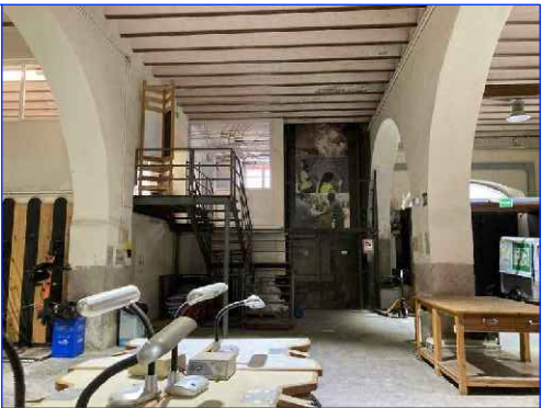
CONSTRUCCIÓ DEL NUCLI D'ESCALA PRINCIPAL
