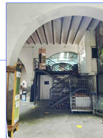
MUNTATGE DE NOU ASCENSOR ADAPTAT
