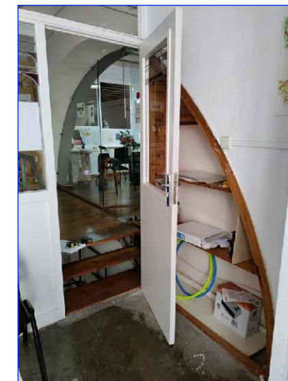
CONSTRUCCIÓ DEL NUCLI D'ESCALA PRINCIPAL
