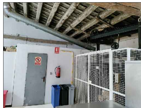
1.MUNTATGE DE NOU ASCENSOR ADAPTAT 3.CONSTRUCCIÓ DEL NUCLI D'ESCALA PRINCIPAL
