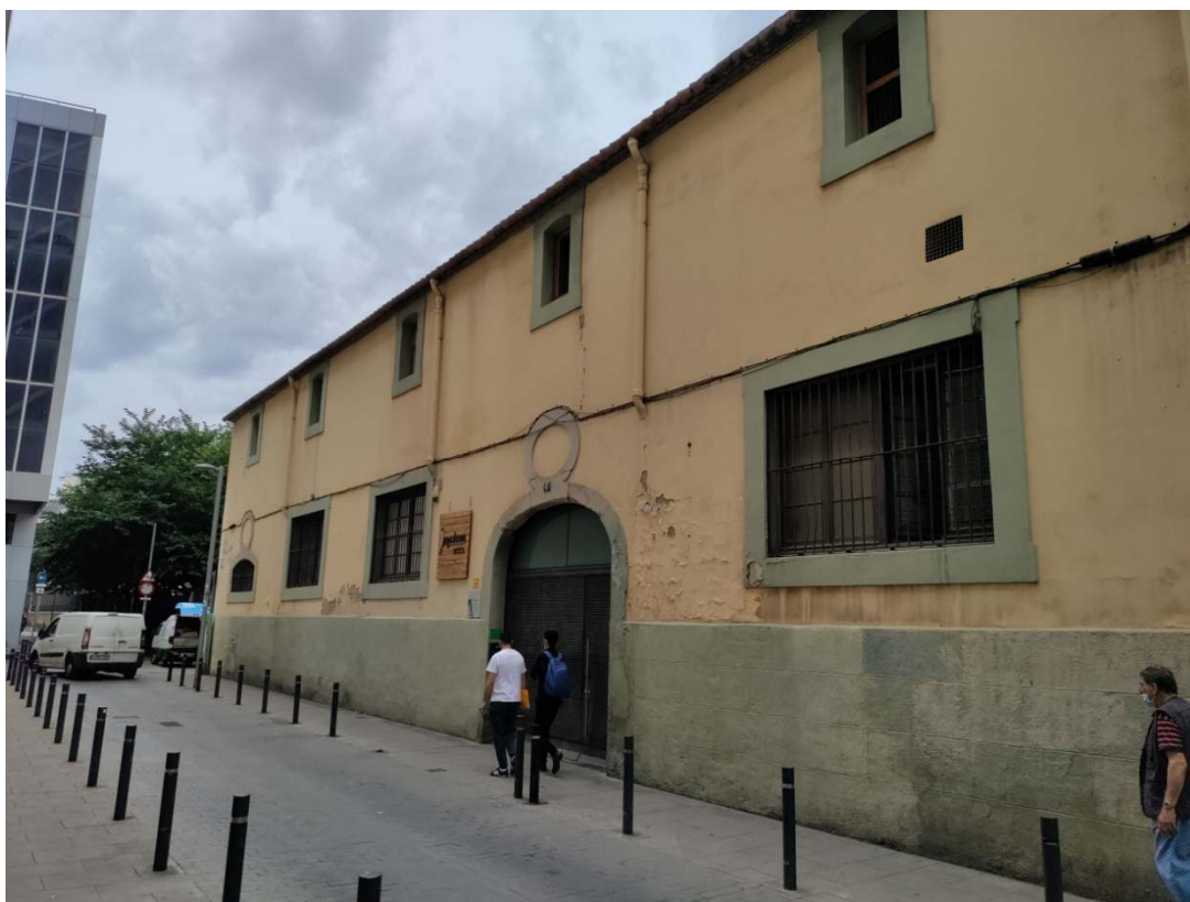
Façana carrer de les Tapies
