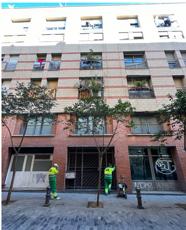
F1 – Façana a carrer
