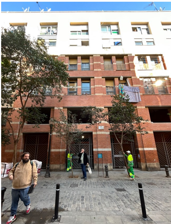
F1 – Façana a carrer
