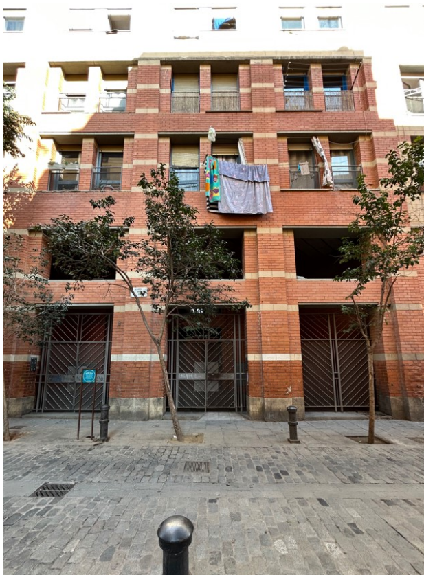
F1 – Façana a carrer
