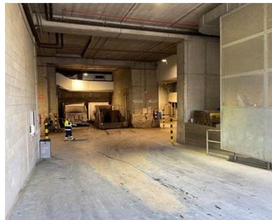
Imatge de la zona d'aparcament de vehicles
