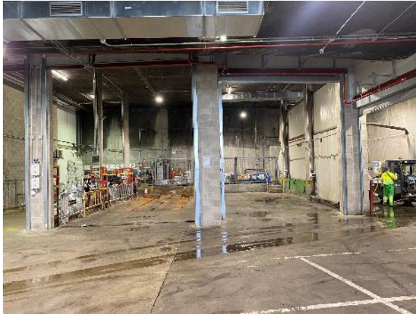
Imatge de la zona tècnica
