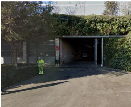
Imatge de l'accés de vehicles
