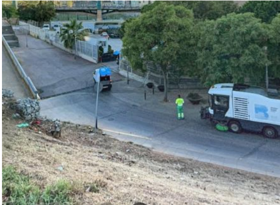
Imatge de l'accés de vehicles des de la cruïlla entre els carrer de Lepant/Alí Bei
