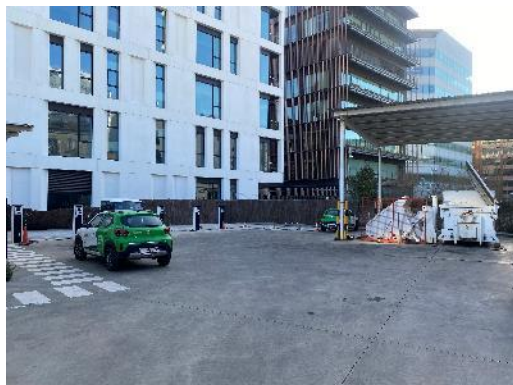
Imatge de la zona tècnica
