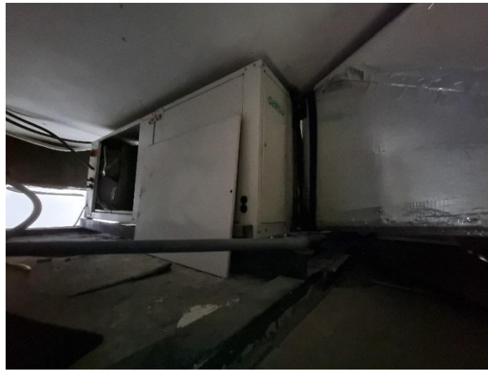
Maquina existent a retirar
