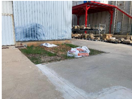
Zona sense pavimentar del pati exterior posterior a l'edifici vell
