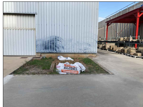
b. Zona sense pavimentar del pati exterior posterior a l'edifici vell
