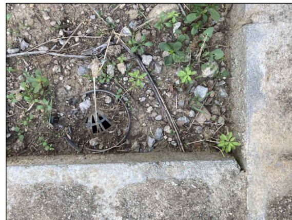
d. Desaigües en la zona sense pavimentar a mantenir, netejar e. Zona sense pavimentar del pati exterior posterior a l'edifici vell
