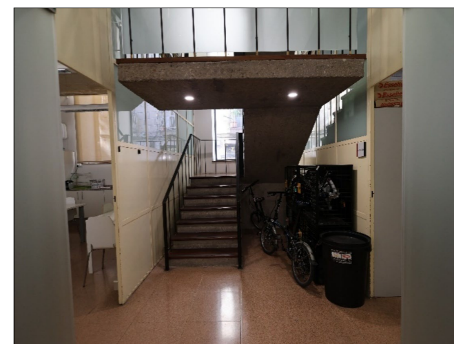
PB14. Arrencament de l'escala secundària o de servei.
