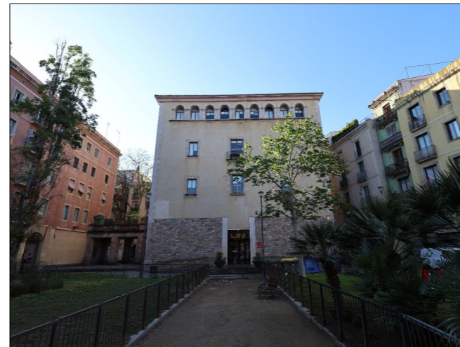
Vista general i de context de la façana posterior (nord).
