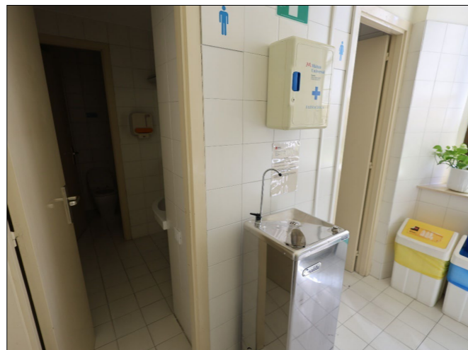
P2.6. Lavabos de la segona planta.
