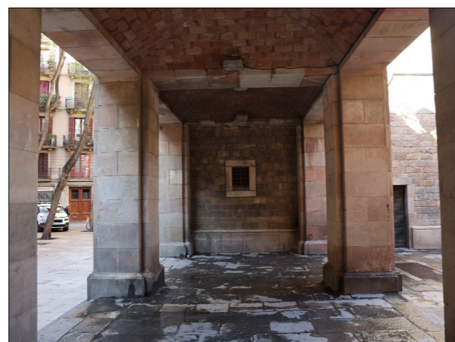
Porxada adossada, vista des de l'interior en direcció a l'edifici.
