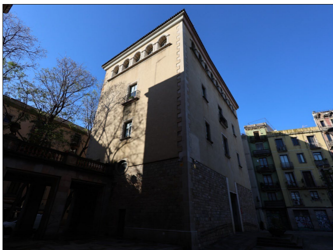
Vista angular de l'edifici, amb les façanes est i nord.
