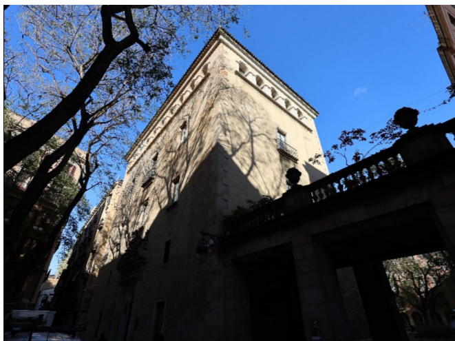
Vista general de la façana de la façana principal des del sud-est.
