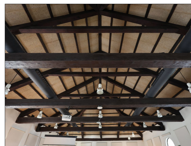
P3.5. Vista de les encavallades i tirants de la coberta.
