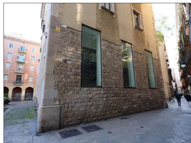
Detall de les finestres inferiors (1984) de la façana oest.
