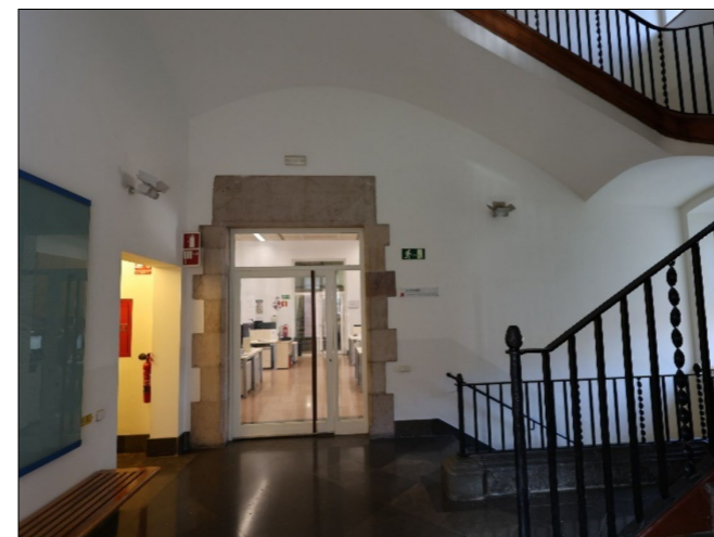
P1.3. Replà-vestíbul, amb la porta d'accés antiga.
