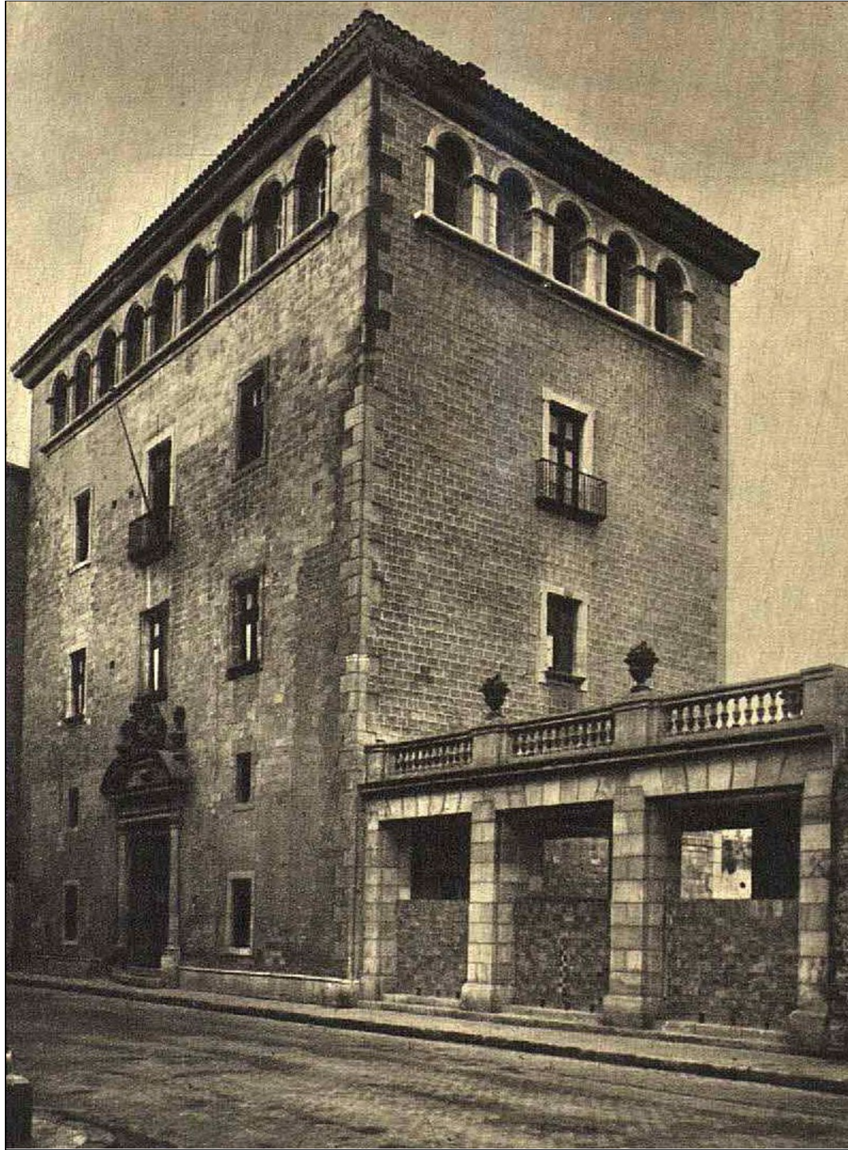
Fotografia del cos de l'antic convent un cop finalitzades les obres de reconstrucció, l'any 1953 92 .
