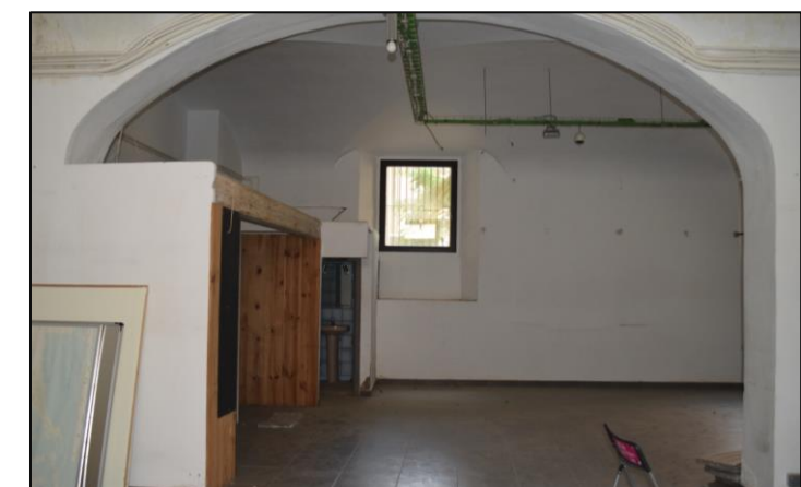
Vista de l'espai diàfan de doble nau, amb eix central de pilars de maó sobre el qual descansen arcades. Font: AMDCV.
