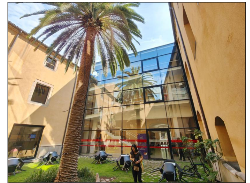
Sobre aquestes línies vista del llenç de vidre, façana posterior al pati de la palmera. A sota, vista de la crugia ampliada; a la dreta el límit original i la paret mestra. A l'esquerra, la nova línia de façana, en vidre.
