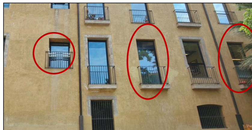
Detall de la façana posterior del cos de Ramelleres en que s'assenyalen les noves obertures practicades vers inicis de segle XX.
