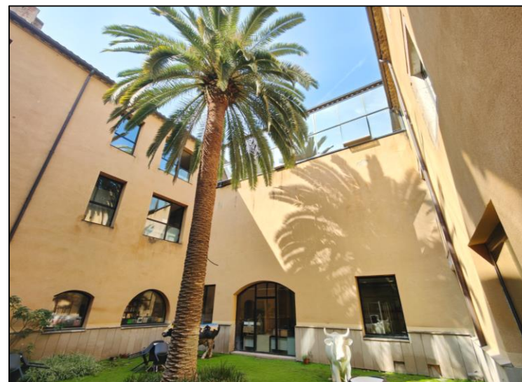
Vista general de la façana est
