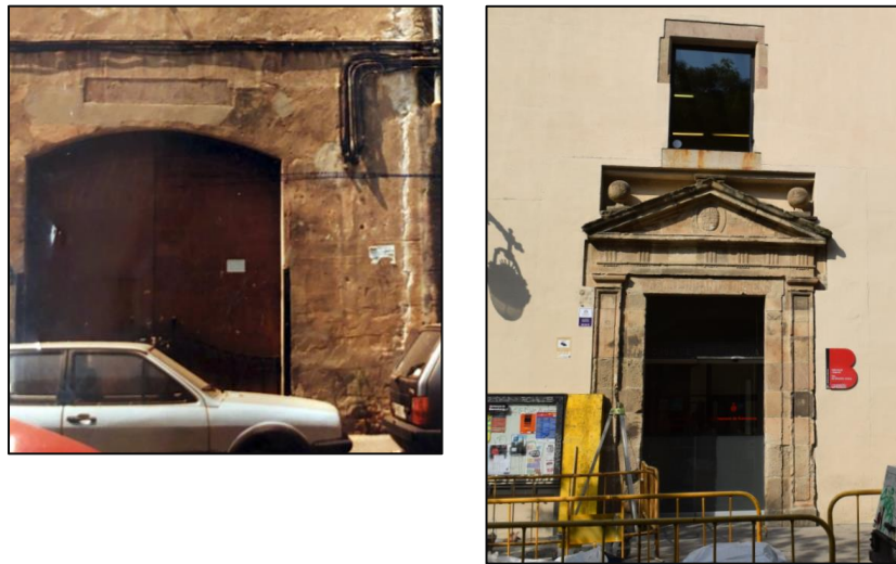
A l'esquerra, vista de la porta en arc rebaixat i llinda de pedra visible pel retall en el revestiment. A la dreta, portalada a l'actualitat, després del trasllat. Font: AMDCV.
