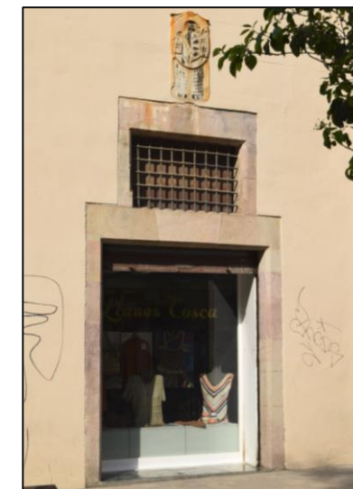
Fotografia de la porta original en el seu estat actual, després de ser amplificada (nova clau d'arc pla) i detall de l'escut del bisbe.
