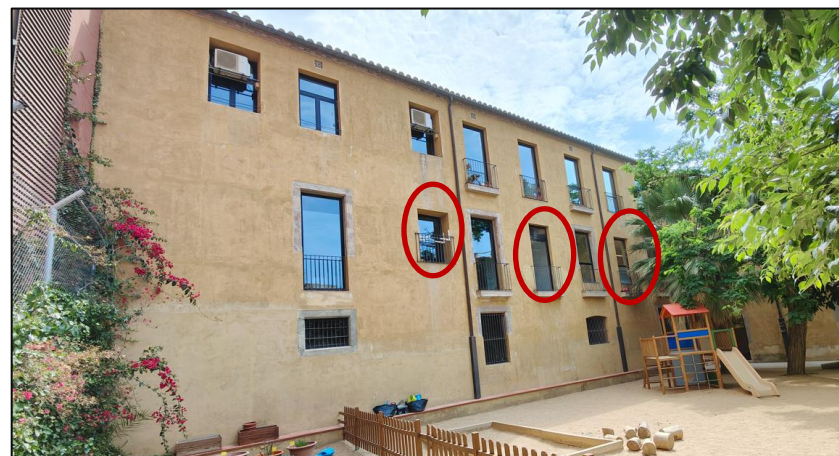
Detall de la façana posterior del cos de Ramelleres en que s'assenyalen les noves obertures practicades vers inicis de segle XX.
