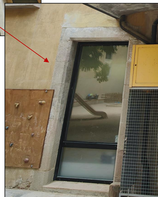
Porta en planta baixa original que es conserva a la façana est del cos transversal.
