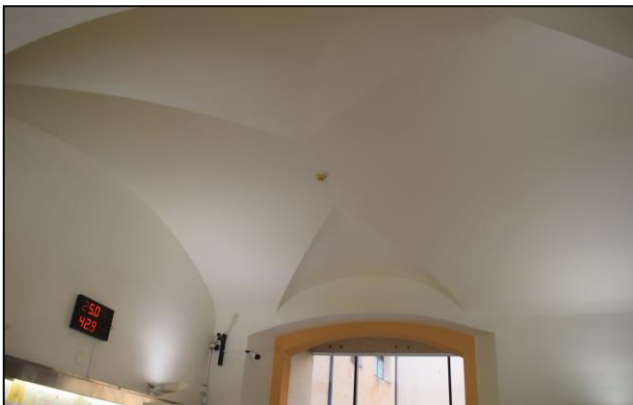
Dues imatges de la volta rebaixada i les llunetes en relació a les obertures al carrer.
