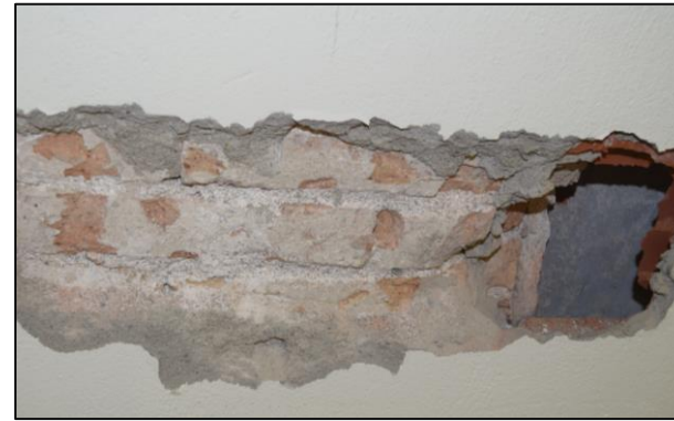
Detall de la cala al mur oest de la construcció.
