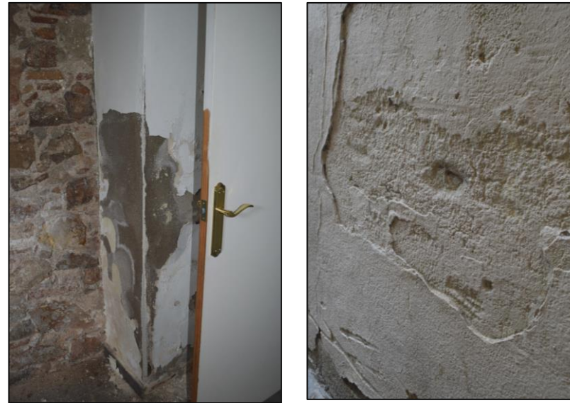
A l'esquerra, vista d'un dels matxons i el revestiment de Portland contemporani. A la dreta, detall de les diverses capes de revestiment en façana.
