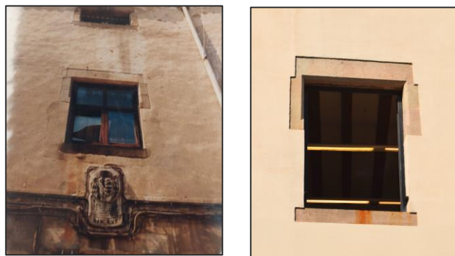
Vista de l'estat de la façana (detall) al 1998 i actualment, en que es pot veure l'ampliació de les finestres, baixant-ne l'ampit. Font: AMDCV.
