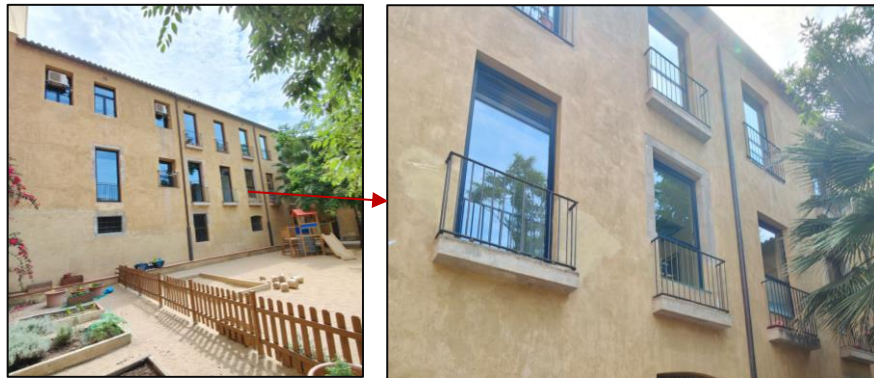
Façana posterior del cos de Ramelleres amb exemple de balcons oberts cap a 1850.
