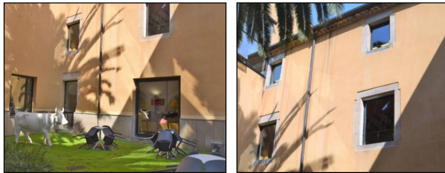
Detalls de les línies d'obertures, amb emmarcaments en pedra de Montjuic.
