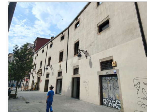
Façana abans, durant i després de les obres iniciades al 1997. Font: AMDCV.
