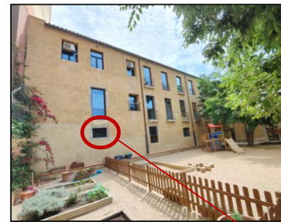
Façana posterior en que s'assenyala la única finestra original que no ha estat interactuada, amb l'emmarcament en pedra complet.
