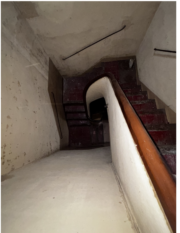
Fotografia de l'escala des de la planta superior.
