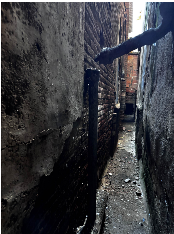
Passadis ubicat entre la masia i l'edific annex.
