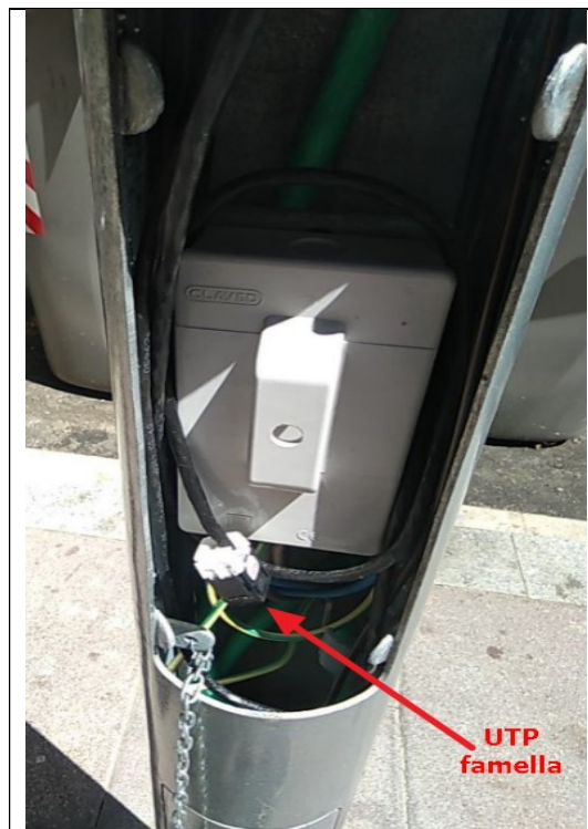
Exemple cable UTP RJ45 femella
