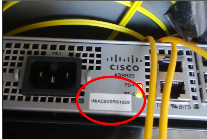
Il·lustració 4. Exemple retolació equip de xarxa
