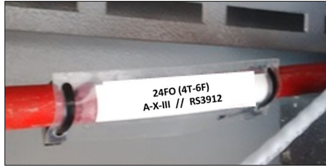
Il·lustració 6. Exemple retolació màniga de fibra
