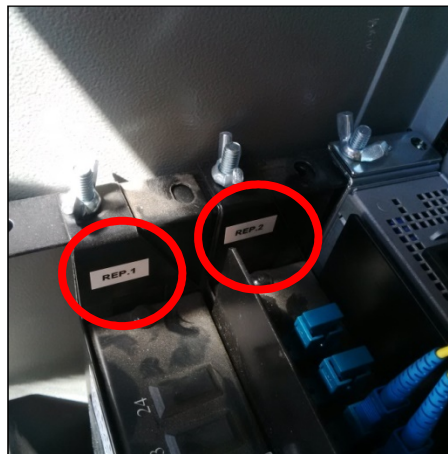
Il·lustració 5. Exemple retolació Repartidors de fibra
