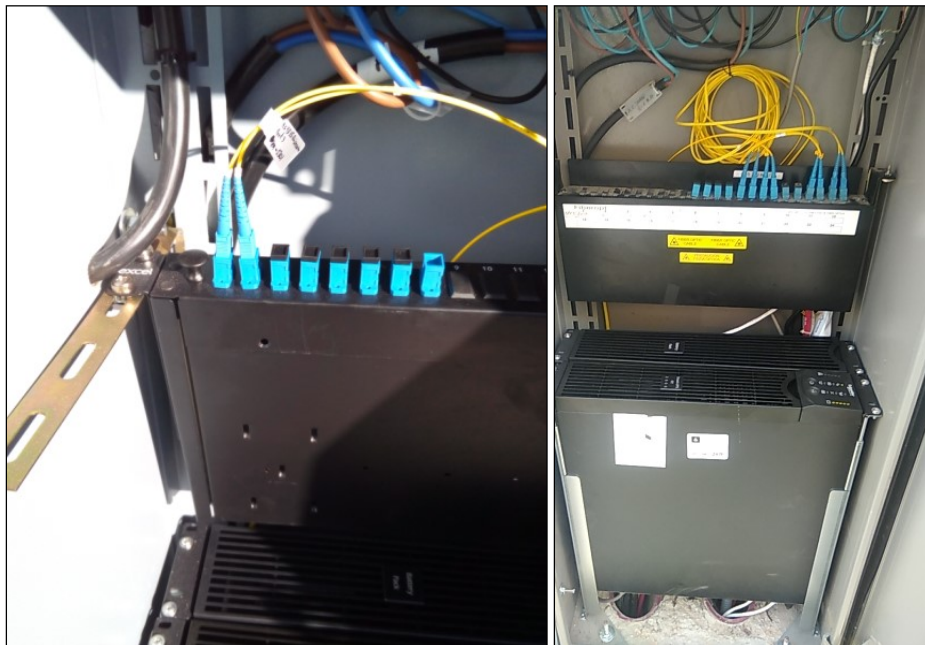
Il·lustració 2. Exemple instal·lació vertical
