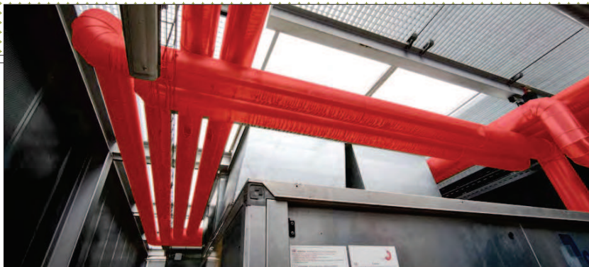
CANONADES D'AIGUA QUE ES REINSTAL·LEN
