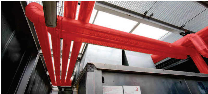
CANONADES D'AIGUA QUE ES REINSTAL·LEN
