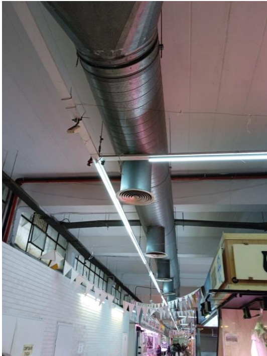
Conductes al interior del mercat. Elements de difusió.
