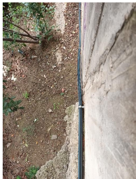
Canonada primària a tocar mur, vist des de dalt.
