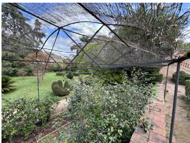
Imatges 240918-45 i 29. Exemple de deformació de biga en gelosia deformada i de colonització de vegetació entapissant d'un tram de corretges.
