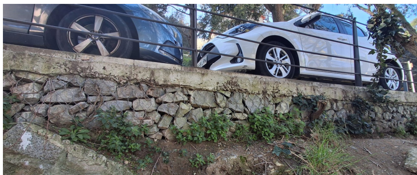
Fotografia d'exemple d'un mur de gabions amb vial
