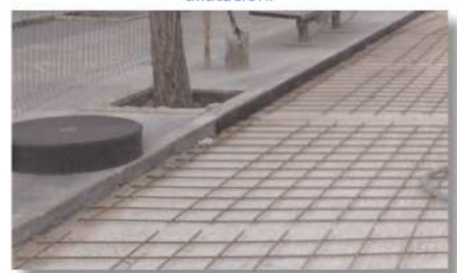
Detall execució de juntes de dilatació amb elements compressibles. Guía técnica IECA. Diseño y ejecución de junta en pavimentos y soleras de hormigón.
