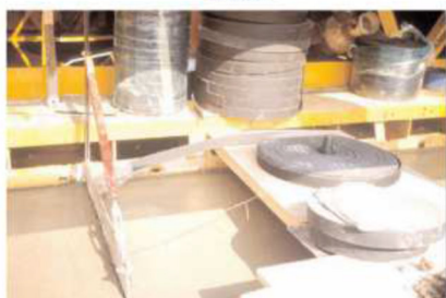
Detall execució de juntes de dilatació amb elements compressibles. Guía técnica IECA. Diseño y ejecución de junta en pavimentos y soleras de hormigón.
