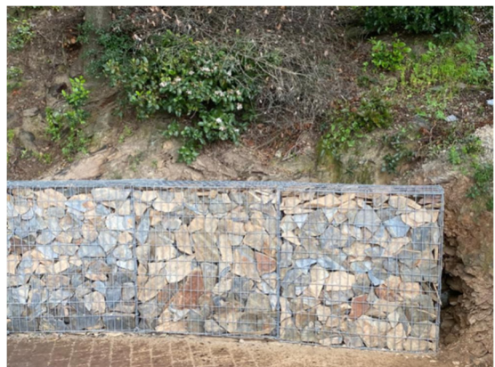
Fotografia dels gabions existents al c. d'Orellana
