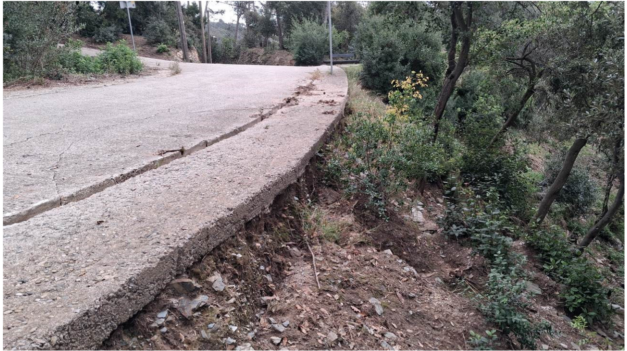
Deslligat de la vorera amb la calçada d'un tram del carrer dels Satèl·lits. Àmbit 01
