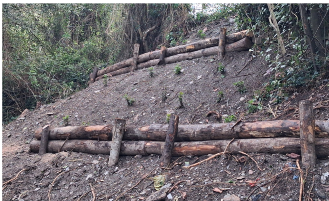
Imatge de referència de palissades de troncs
