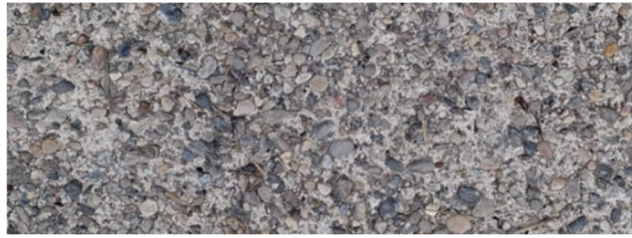
Acabat superficial de palet de riu vist existent a la vorera
