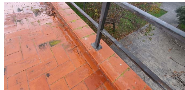
Imatges generals de la coberta.
