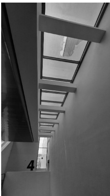
Vista de la lluerna per l'interior
