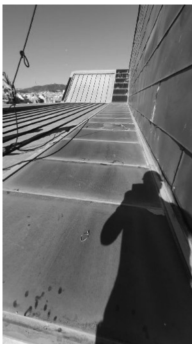
Vista de la lluerna per l'exterior
