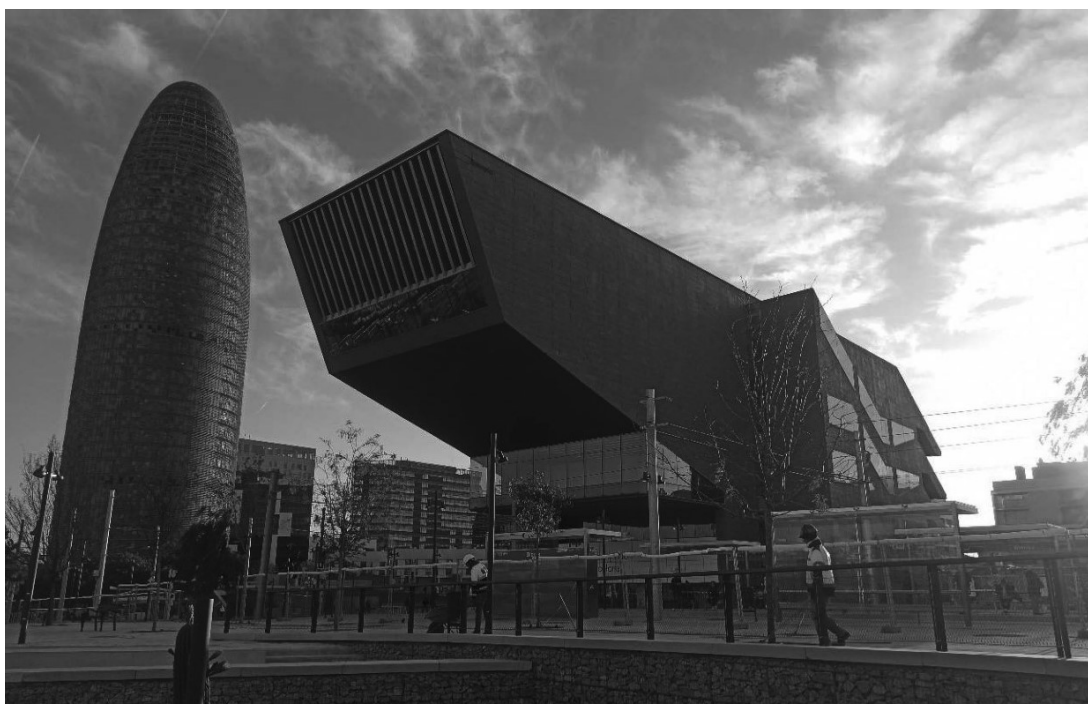
Façana NO abocada a la Plaça de les Glòries
