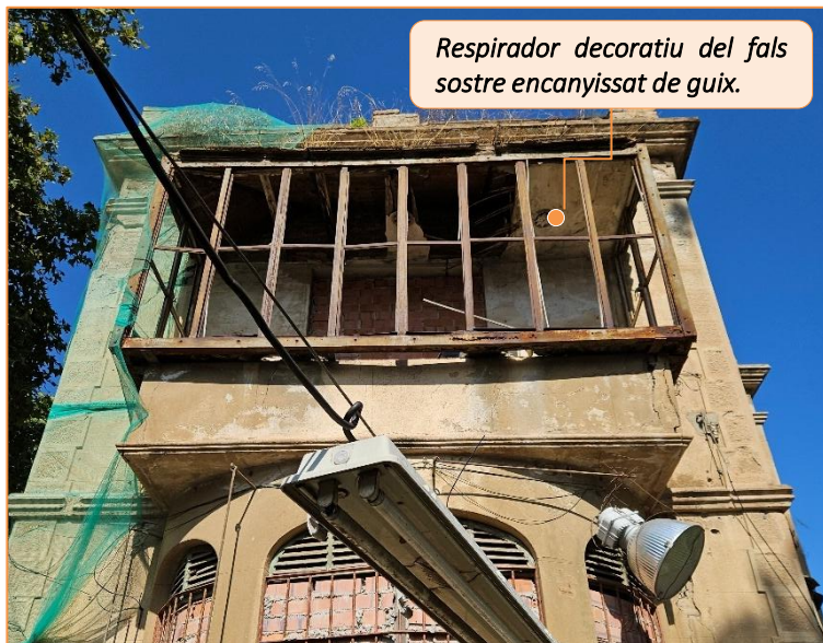
Estructura metàl·lica original o de reforç en procés d'oxidació.
