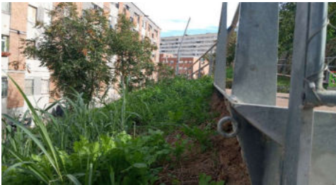
Anclaje tipo inspeccionado
