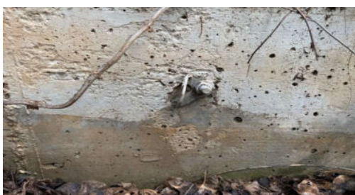
Anclaje tipo localizado
