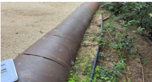
Zona tipo inspeccionada
