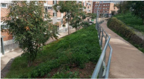
Zona de las barandillas con anclajes
