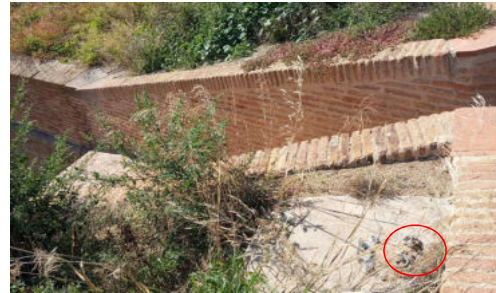
Anclajes numero 2 y 3
