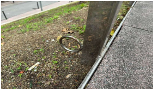
Anclaje tipo localizado
