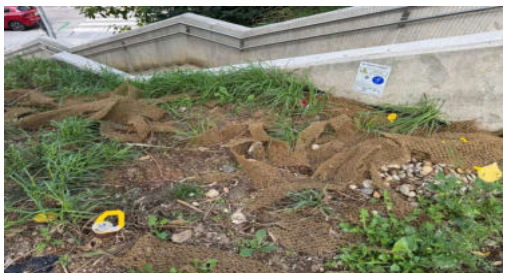
Anclaje tipo localizado
