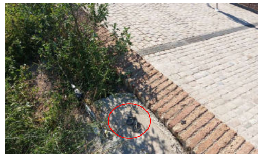
Anclajes numero 9 y 10
