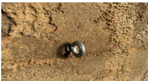
Anclaje tipo anilla localizado
