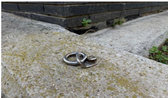
Anclaje tipo inspeccionado
