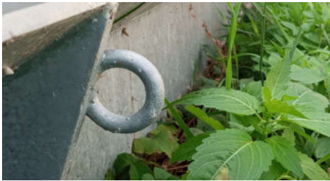
Anclaje tipo inspeccionado
