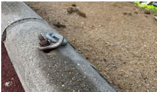
Anclaje tipo localizado
