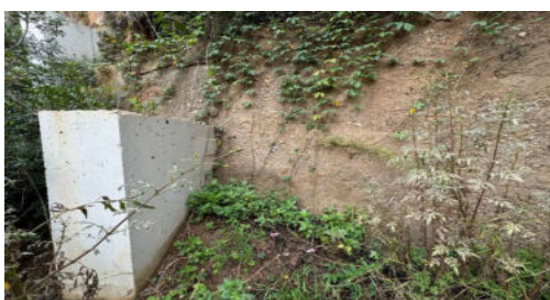
Zona tipo inspeccionada
