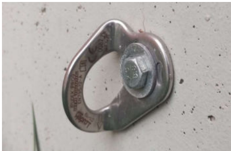
Anclaje numero 2 y 3
