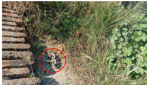
Anclajes numero 1 y 2
