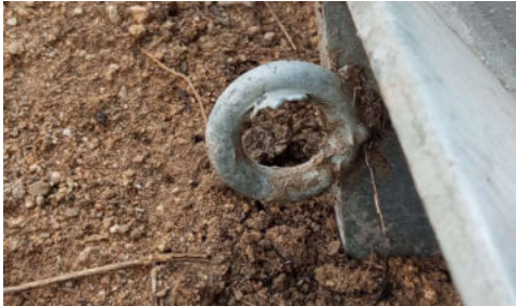
Anclaje tipo inspeccionado
