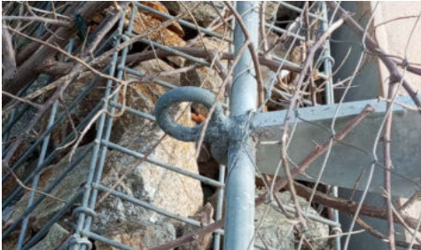
Anclaje tipo inspeccionado
