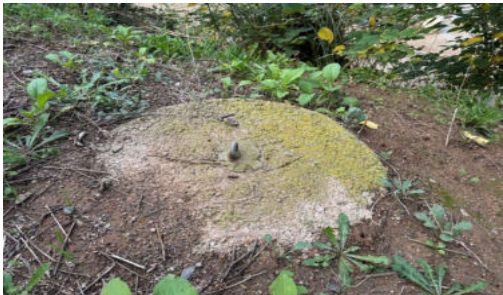
Anclaje tipo localizado
