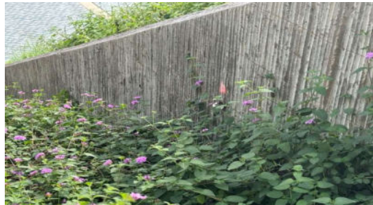
Anclaje tipo inspeccionado
