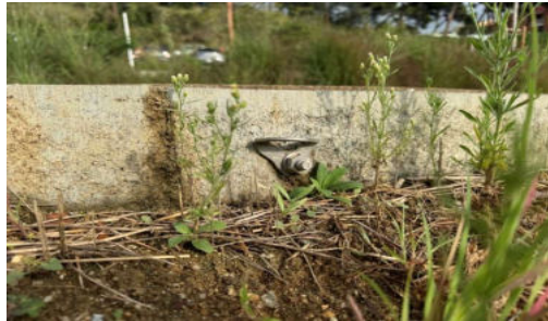
Anclaje tipo localizado
