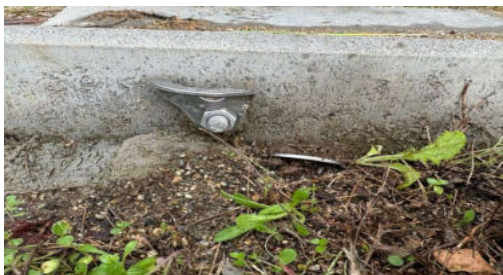
Anclaje tipo localizado
