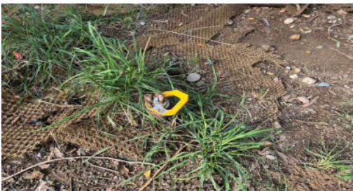
Anclaje tipo localizado
