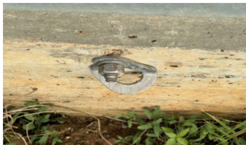
Anclaje tipo localizado
