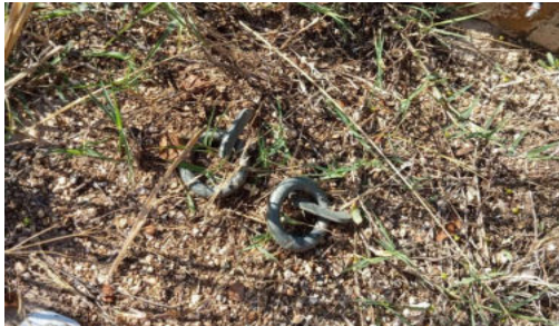
Anclajes numero 6 y 7
