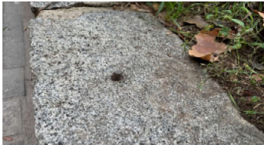
Anclaje tipo sustraído
