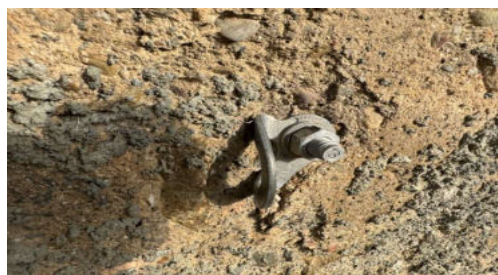
Anclaje tipo localizado
