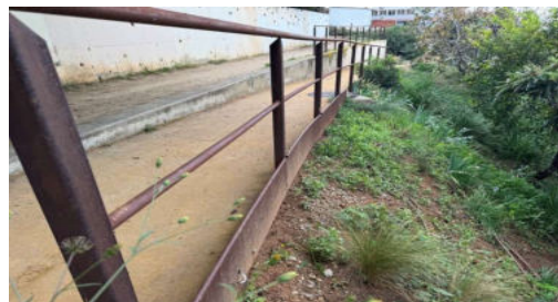
Zona tipo inspeccionada
