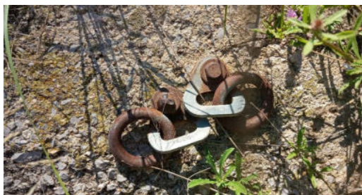
Anclajes numero 3 y 4
