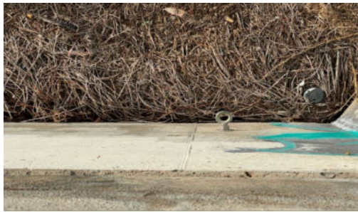
Anclaje tipo localizado
