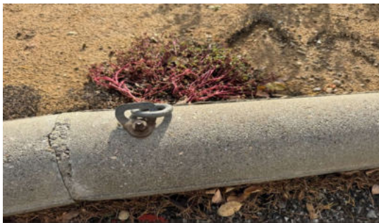
Anclaje tipo localizado
