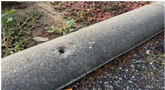
Anclaje tipo sustraído
