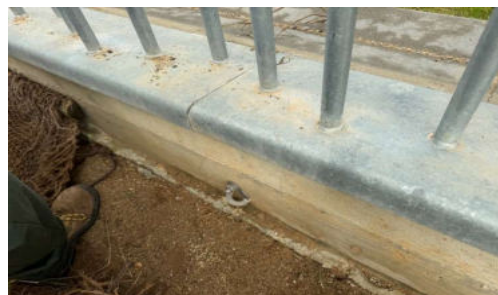
Anclaje tipo localizado
