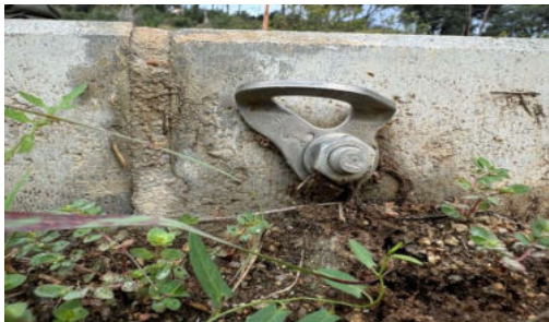
Anclaje tipo localizado
