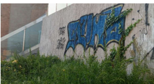
Zona tipo inspeccionada
