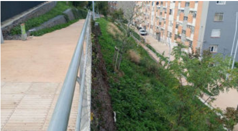
Zona de las barandillas con anclajes
