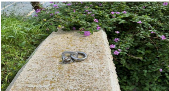
Anclaje tipo inspeccionado
