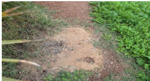
Punto sin anclaje 2
