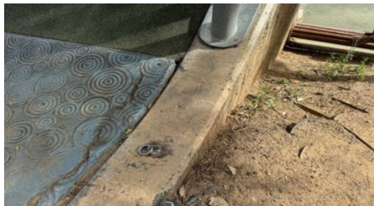
Anclaje tipo inspeccionado
