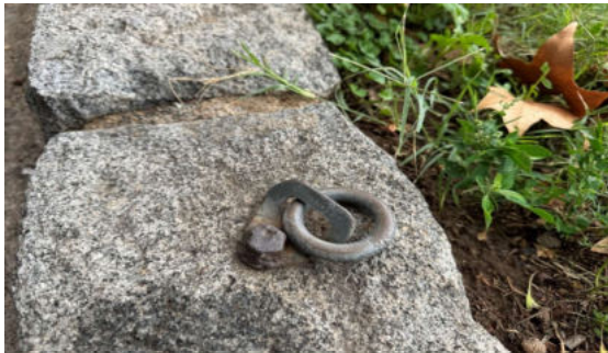
Anclaje tipo localizado
