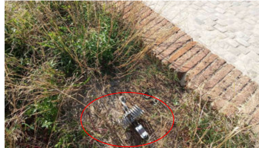
Anclajes numero 6 y 7
