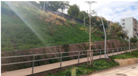
Zona de las barandillas con anclajes
