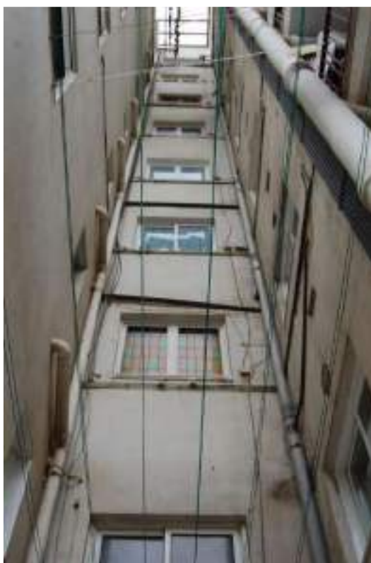
Foto 7 Vista del pati des de l'interior de la finca
