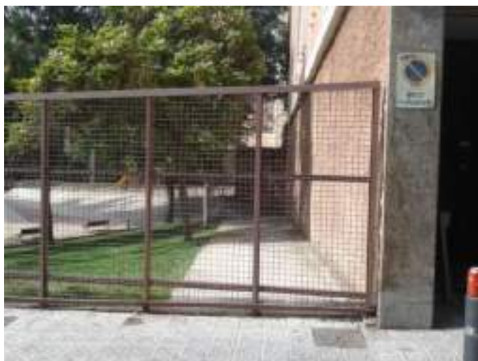
Foto 8 Tanca exterior des del c/Emèrita Augusta
