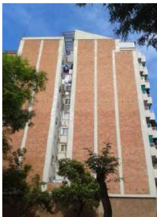
Estat actual de la mitgera
