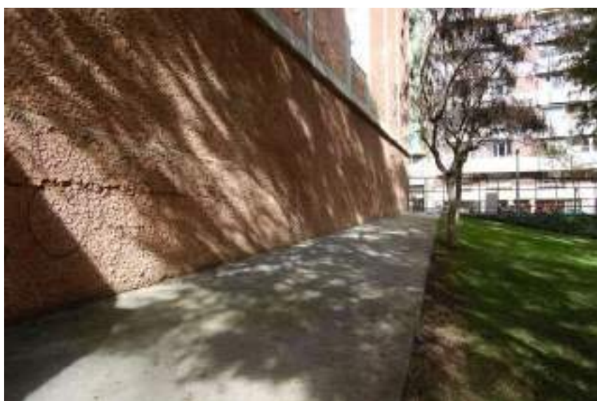
Foto 3 Sòcol i paviment de formigó.
