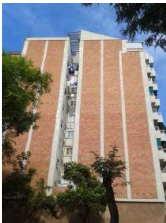
Foto 5 Estat actual de la mitgera
