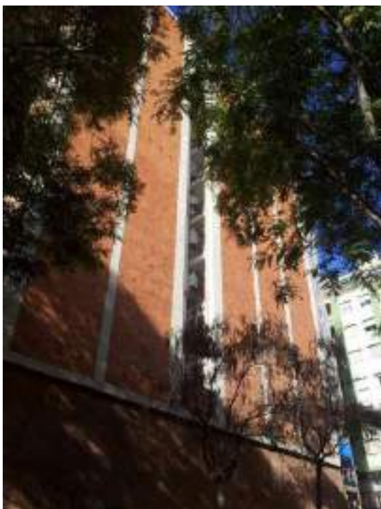
Estat actual de la mitgera
