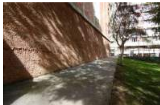
Sòcol i paviment de formigó
