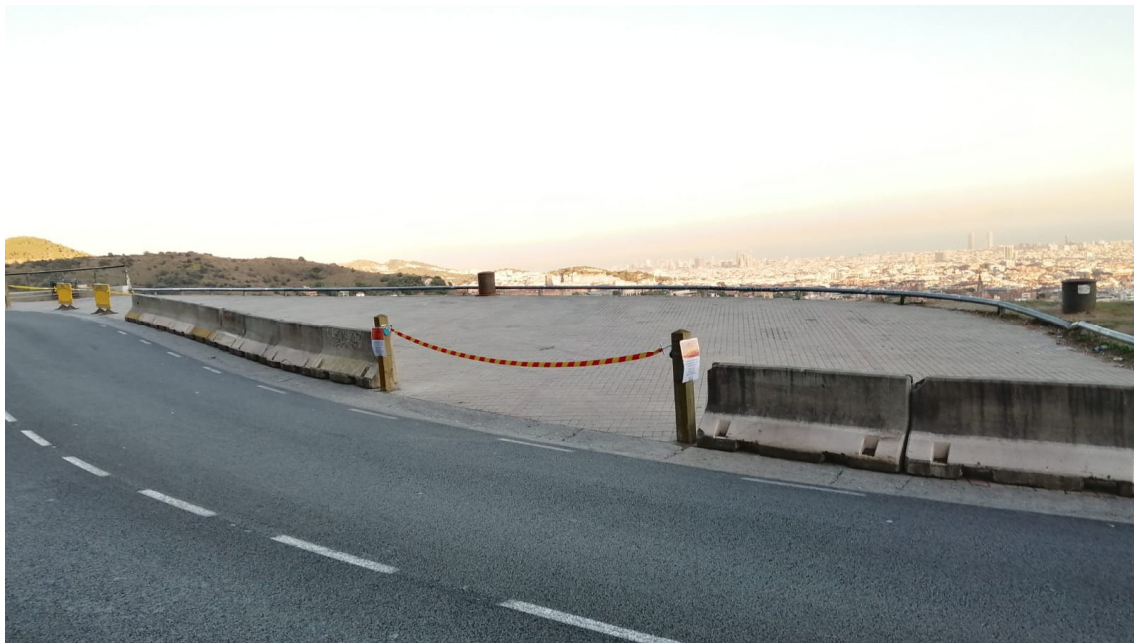
Tancament amb new-jerseys i cadenat d'accés.
