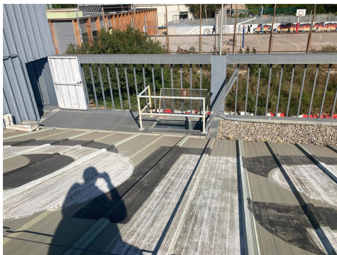
Accés a coberta inferior
