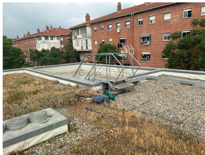
Accés a coberta
