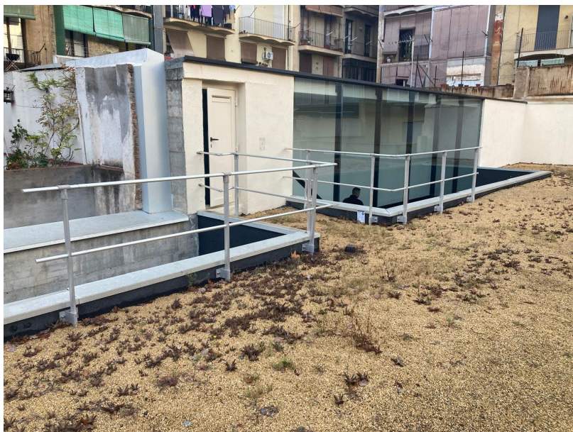
Accés a coberta
