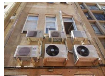
Imatge 43: Façana planta segona
