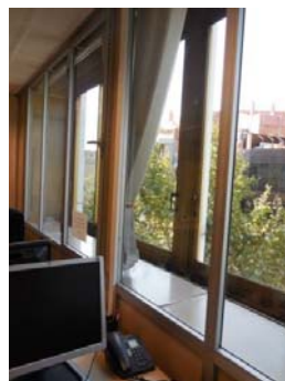
Imatge 79: Façana ventilada
