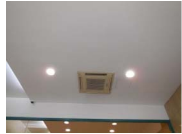
Imatge 46: Unitat interior tipus cassette
