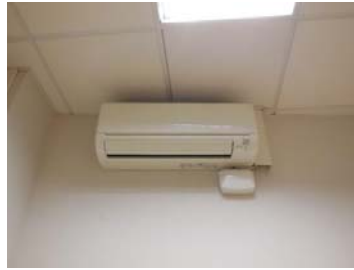
Imatge 45: Unitat interior tipus split amb bomba condensats
