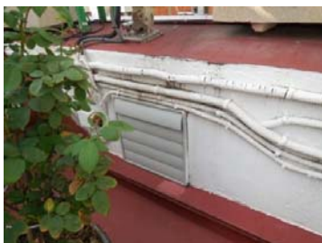
Imatge 48: Ventilació façana
