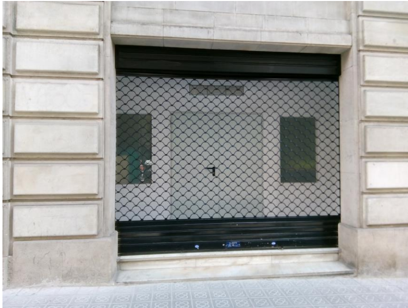
Imatge 9: Imatge exterior amb persiana enrotllable motoritzada
