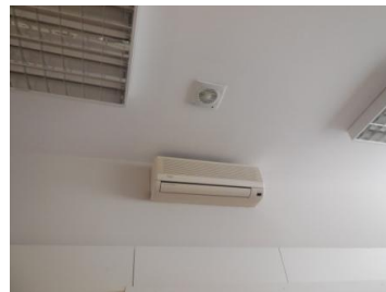
Imatge 19: Extractor sala personal
