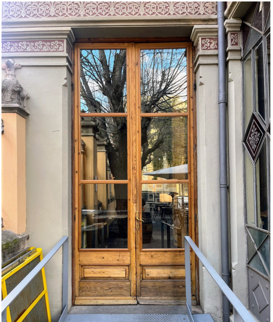
Exterior de la porta a reparar.
