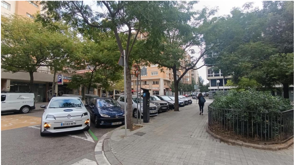
▲ Vista de la vorera a ampliar des de la plaça del Sòl de Baix
