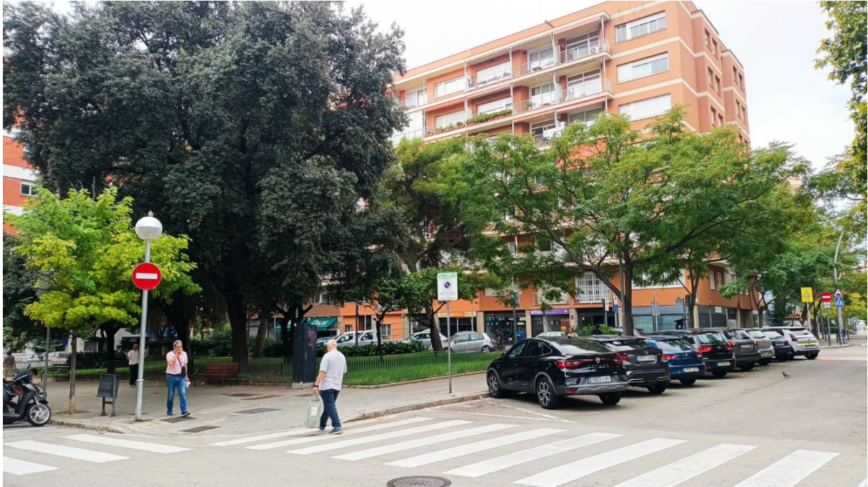
▲ Vista de la vorera a ampliar des del carrer de Lluçà
