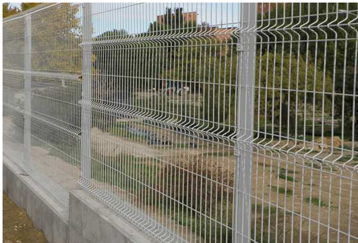
Model orientatiu de malla electrosoldada plegada.
