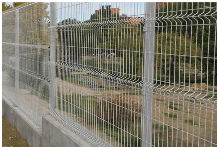
Model orientatiu de malla electrosoldada plegada.
