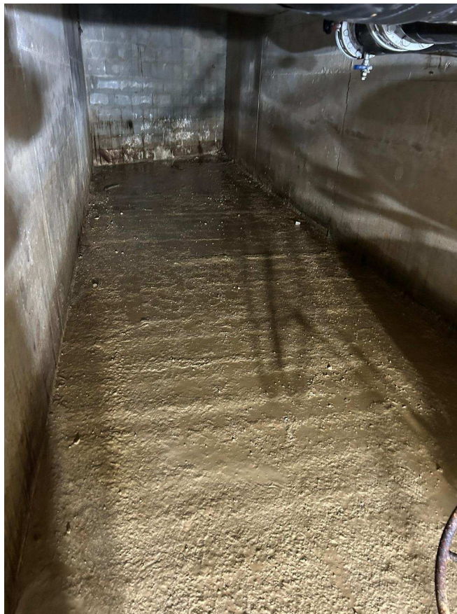
Galeria de Serveis 12. Vista general de la Galeria.
