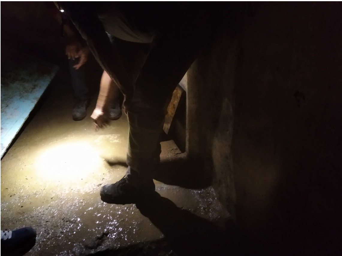
Galeria de Serveis 10. Detall de solera.
