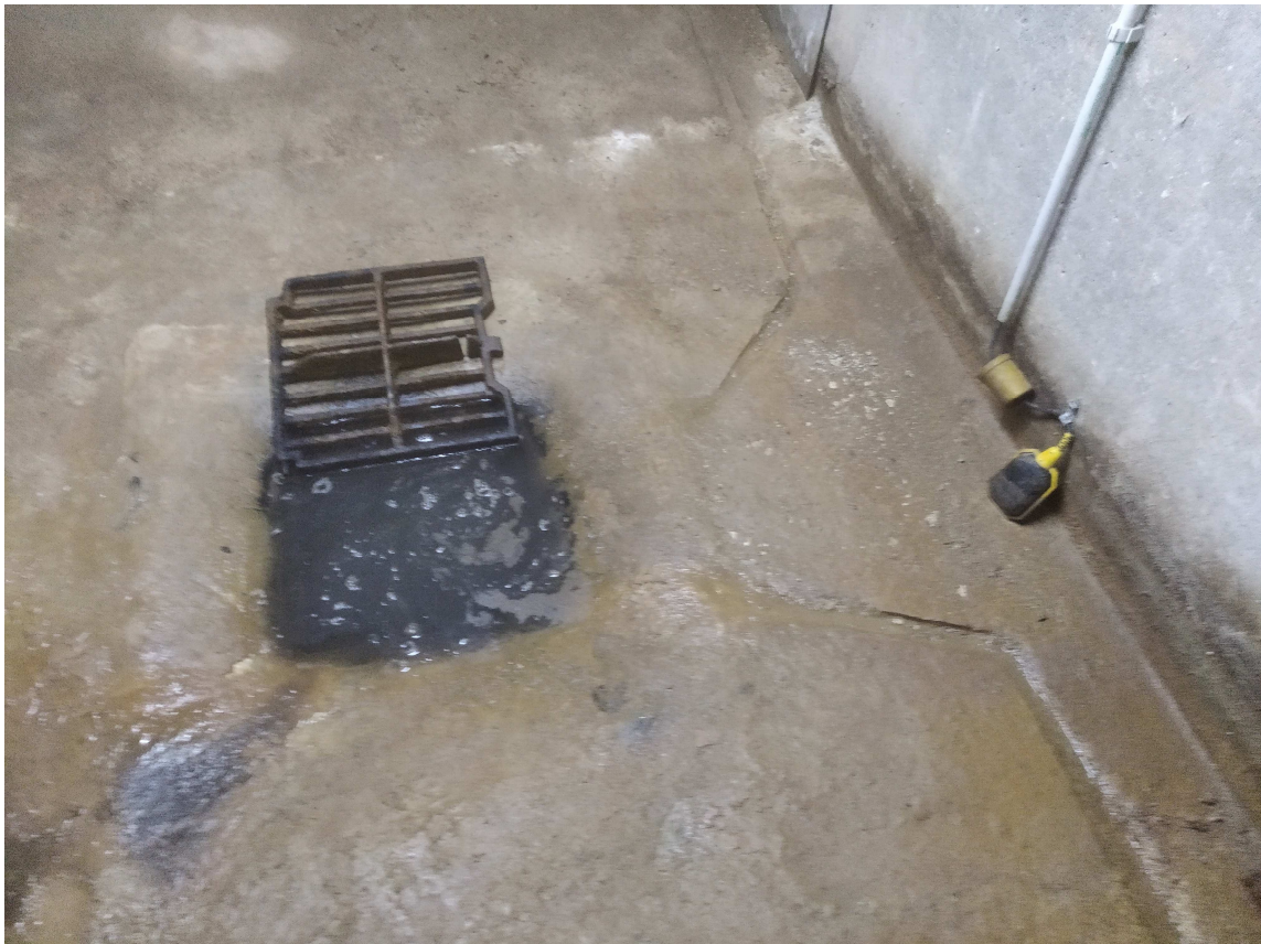
Galeria de Serveis 44. Pou de drenatge.
