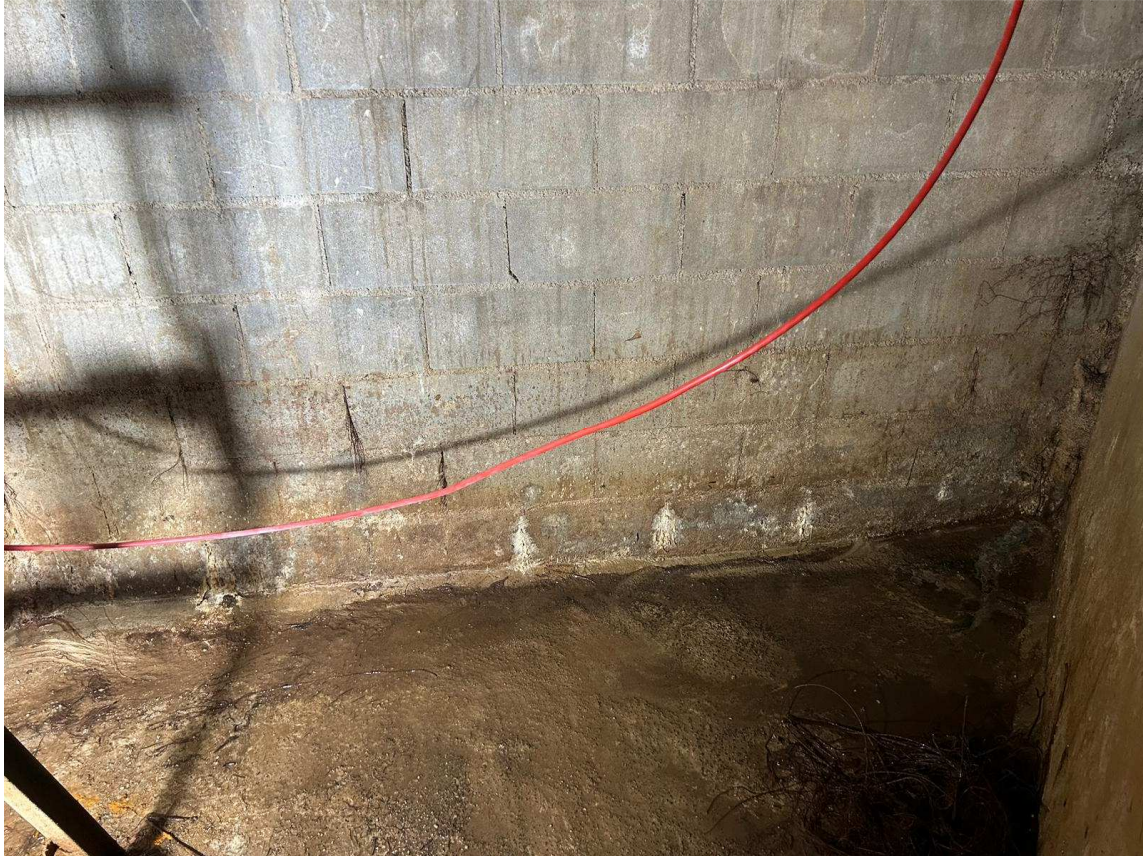
Galeria de Serveis 12. Detall de paret de tancament de bloc.
