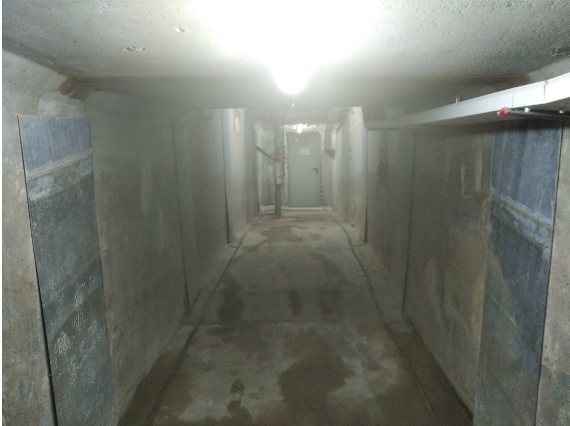
Galeria de Serveis 44. Vista general de la Galeria.
