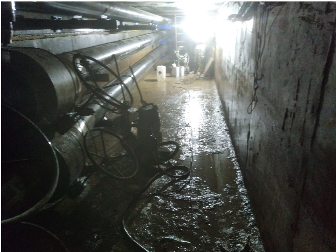
Galeria de Serveis 10. Vista general de la Galeria.
