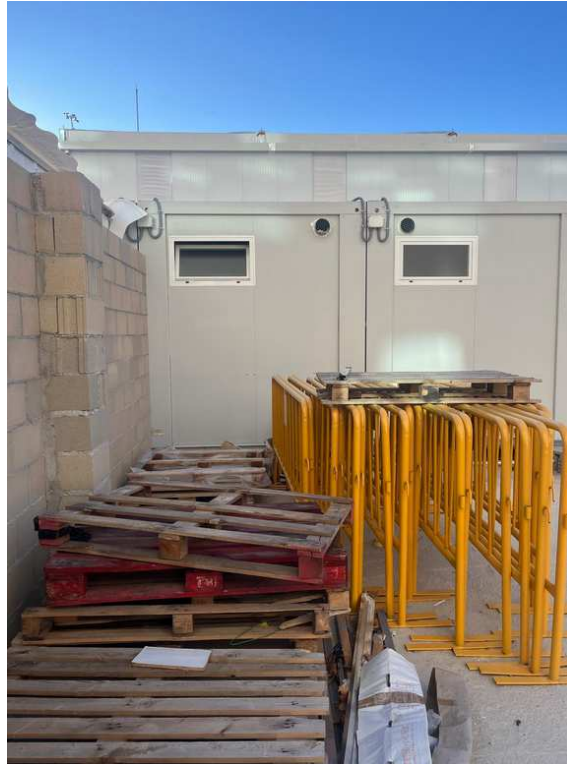
Trasdossat del mur a demolir parcialment i on anirà instal·lat el lavabo
