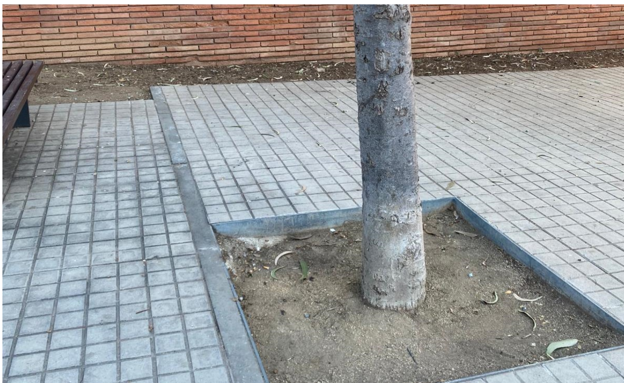
▲ Detall alineació paviment amb encintat
