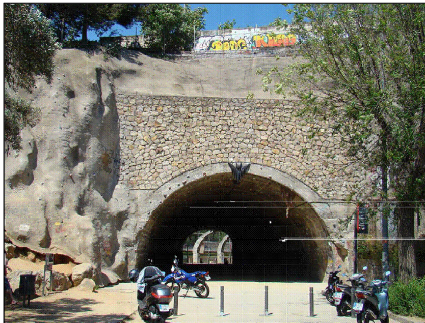
Figura nº 10. Exemple de túnel
