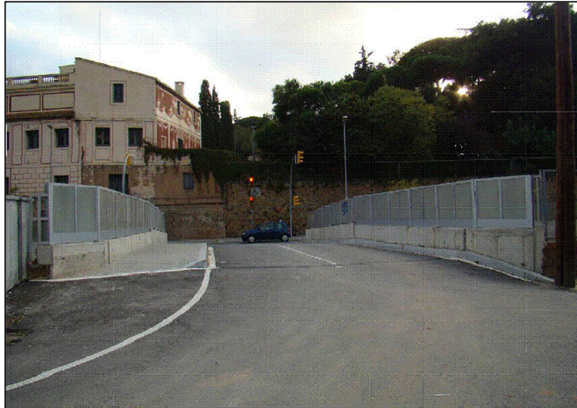
Figura nº 9. Exemple de pont
