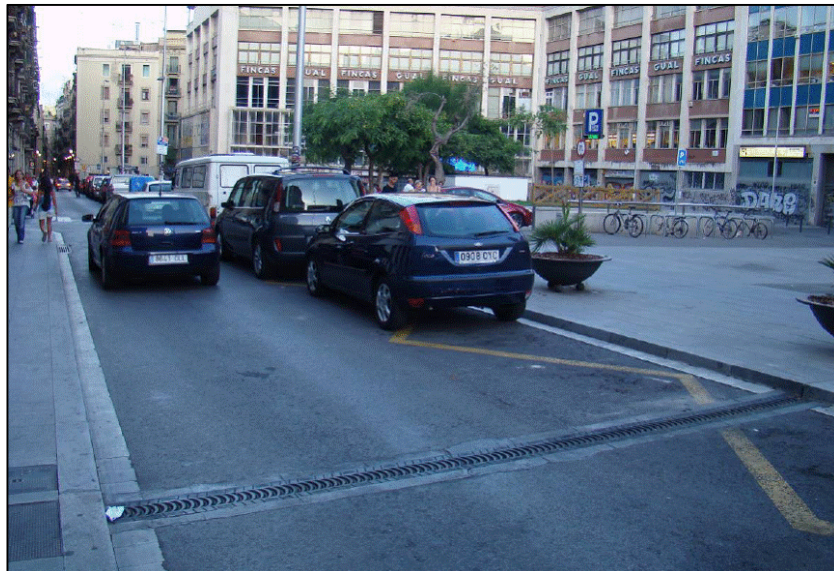
Figura nº 6. Exemple de junta.
