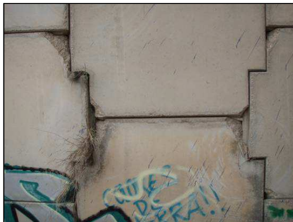
Figura 4.65.1. Vegetación en paramento de muro de tierra reforzada.
