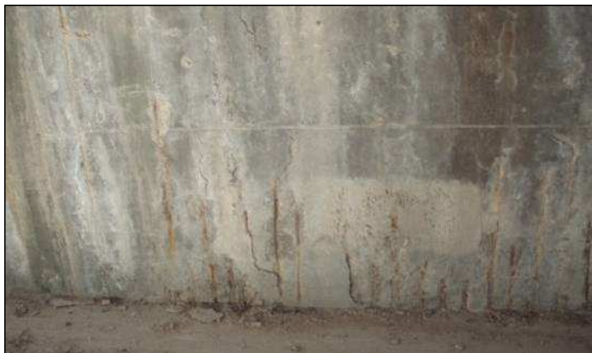
Figura 4.3.1. Armadura vista en pie de hastial.
