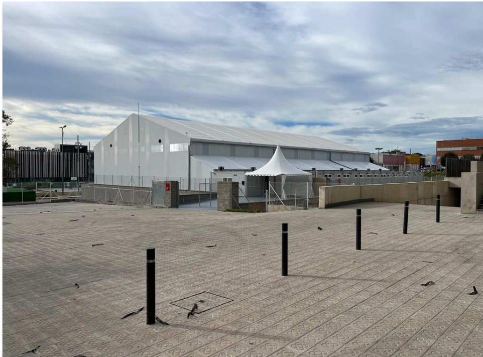
Pavelló provisional Bederrida
