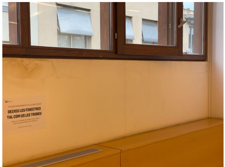
Taques al sostre i paret per filtració d'aigua de la coberta i junta entre fusteria i paret.
