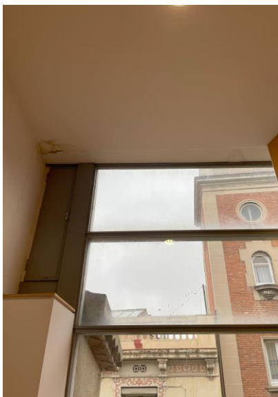
Taques al sostre i paret per filtració d'aigua de la coberta i junta entre fusteria i paret.
