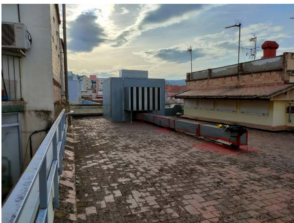
ESTAT DE LA COBERTA PLANA TRANSITABLE
