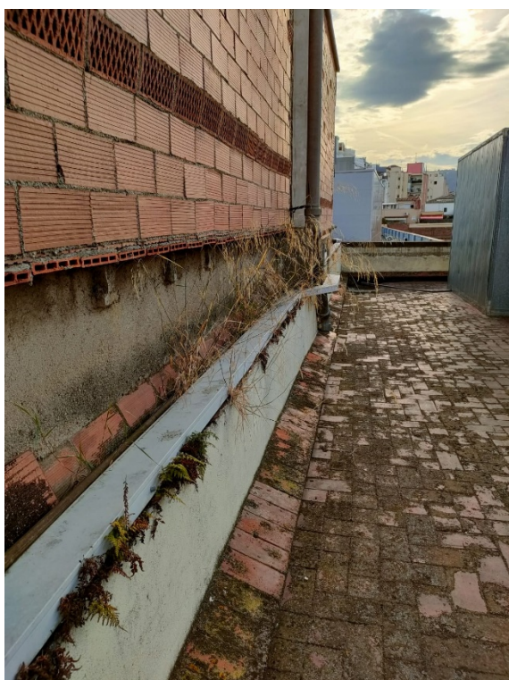
ESTAT ZONA INSTAL·LACIONS
