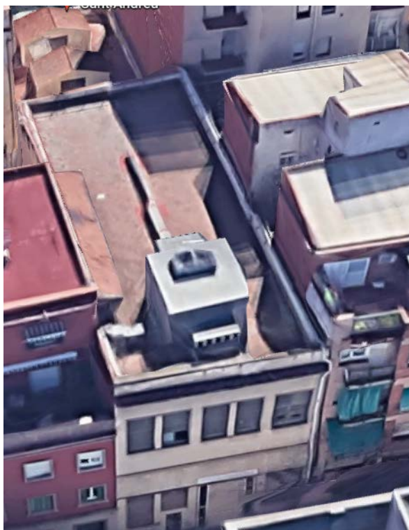
FAÇANA POSTERIOR I COBERTA
