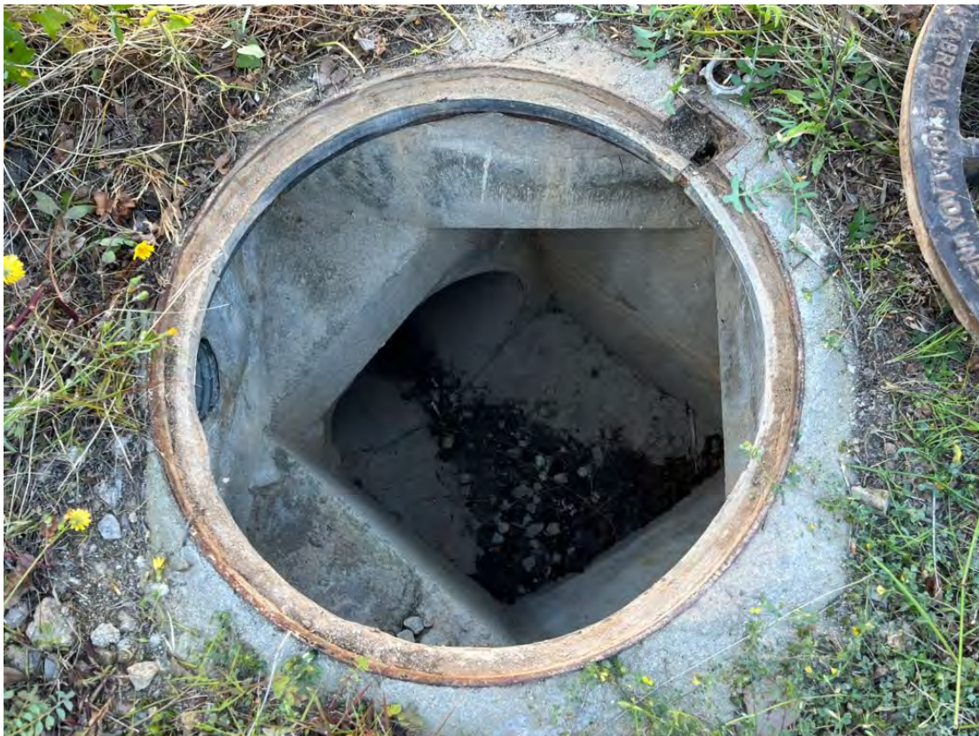
Vista del pou existent de sanejant a l'interior de solar.
