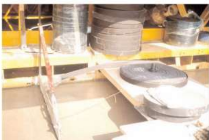
8 Detall execució de juntes de dilatació amb elements compressibles. Guia tècnica IECA. Diseño y ejecución de junta en pavimentos y soleras de hormigón.
