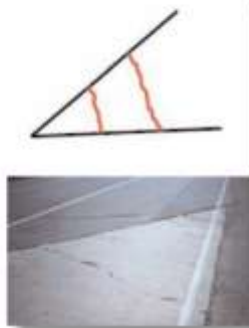
Figura 3. Aparición de fisuras en una cuña debido a un ángulo muy agudo.
