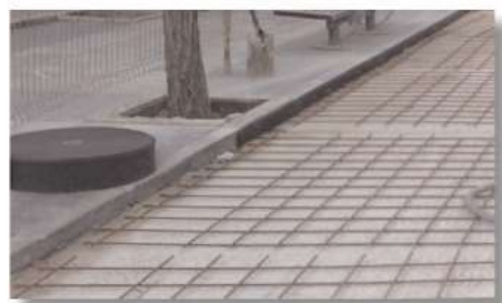
8 Detall execució de juntes de dilatació amb elements compressibles. Guia tècnica IECA. Diseño y ejecución de junta en pavimentos y soleras de hormigón.
