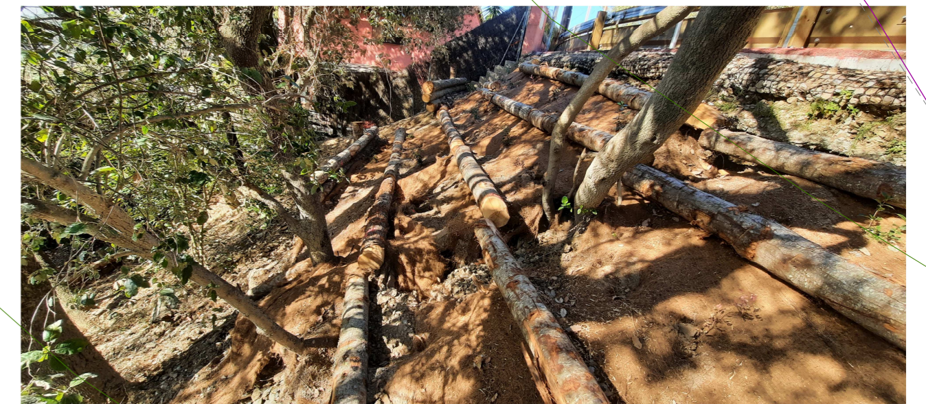
Estat actual de l'entramat existent
