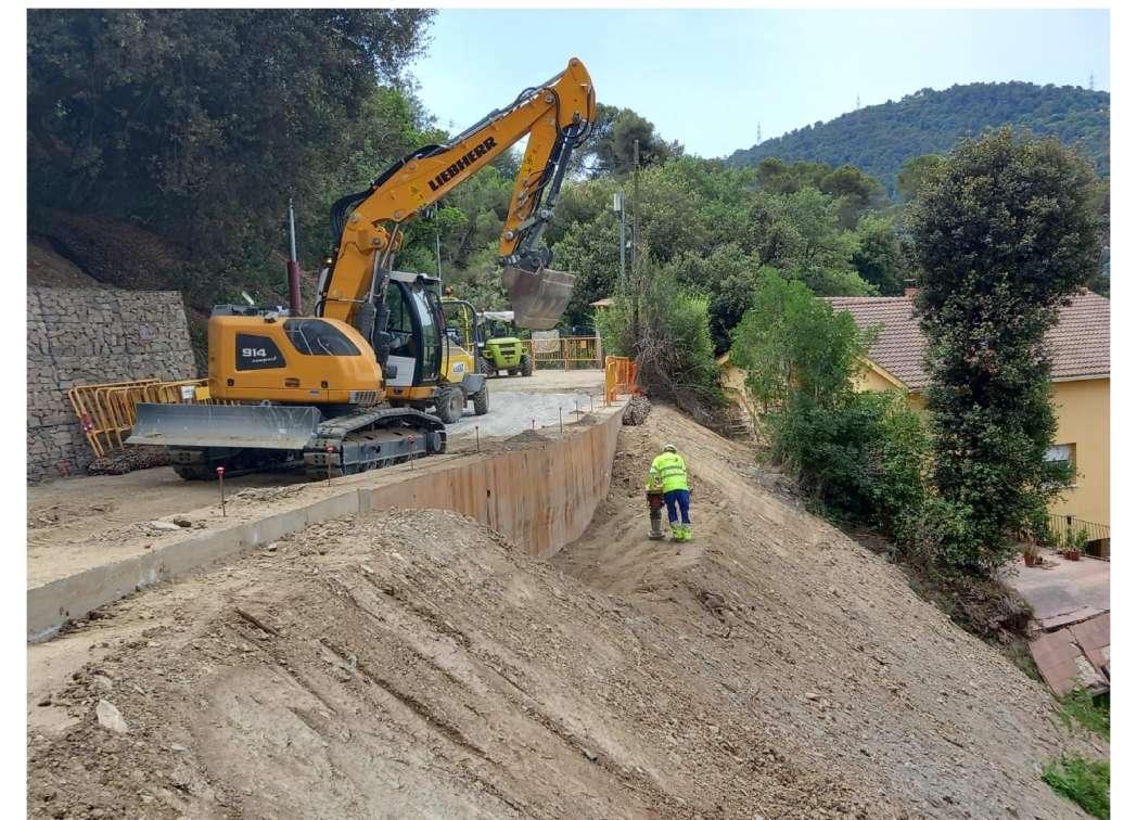
FOTO EXECUCIÓ OBRES PANTALLA MICROPILOTIS
