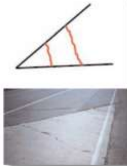
Figura 3. Aparición de fisuras en una cuña debido a un ángulo muy agudo.
