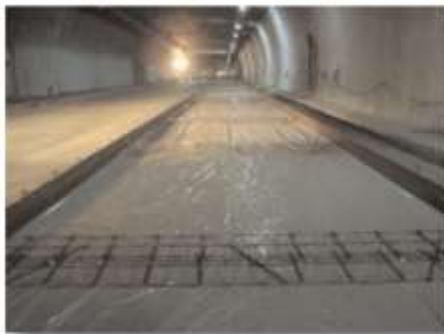
Figura 22. Disposición de pasadores previamente al hormigonado o insertados durante el mismo.
