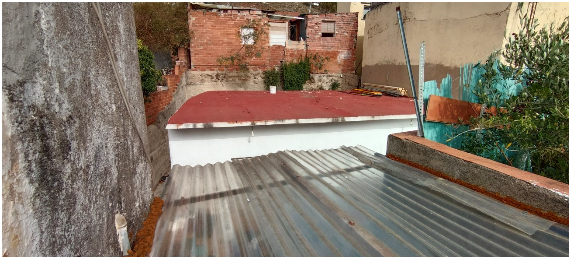
VISTA GLOBAL (DES DE TERRAT EDIFICI C. OJEDA Nº 3)
