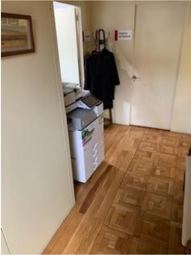
Planta Primera: Distribuidor oficines, cal substituir la franja lineal per peces de parquet de fusta iguals a les existents.
