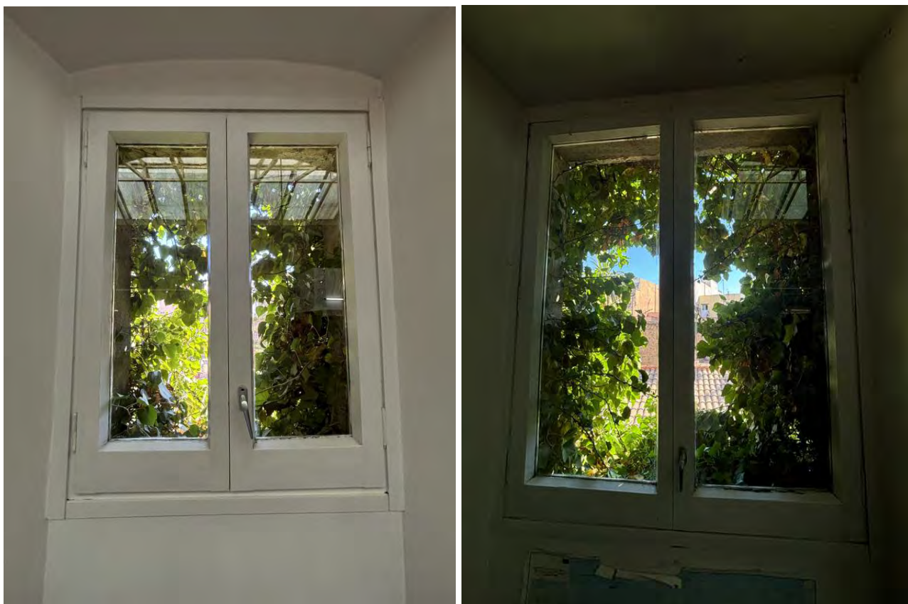
Imatges 240621-57\59. Vistes interiors de les finestres del segon pis, cap al passatge lateral.
