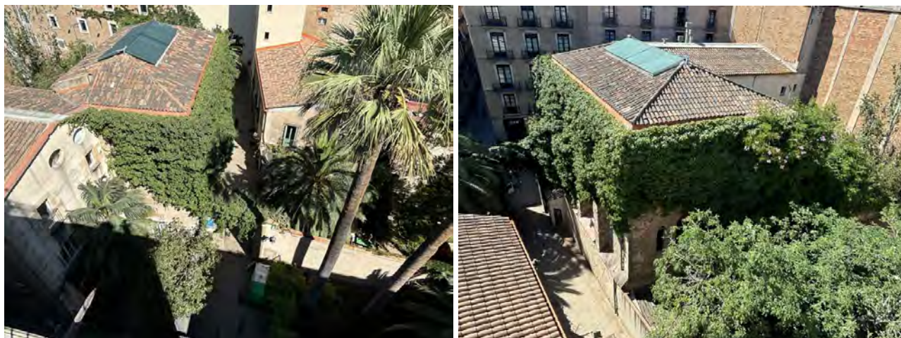
Imatges 240621-61\69. Vistes des d'edificis veïns de l'extensió de la colonització de façanes per heura.
