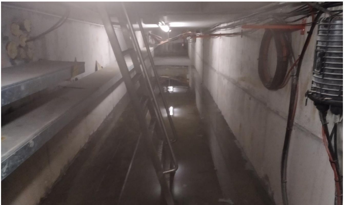
Galeria de Serveis 34. Vista general de la galeria.
