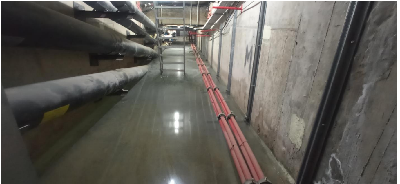
Galeria de Serveis 32. Vista general de la galeria.
