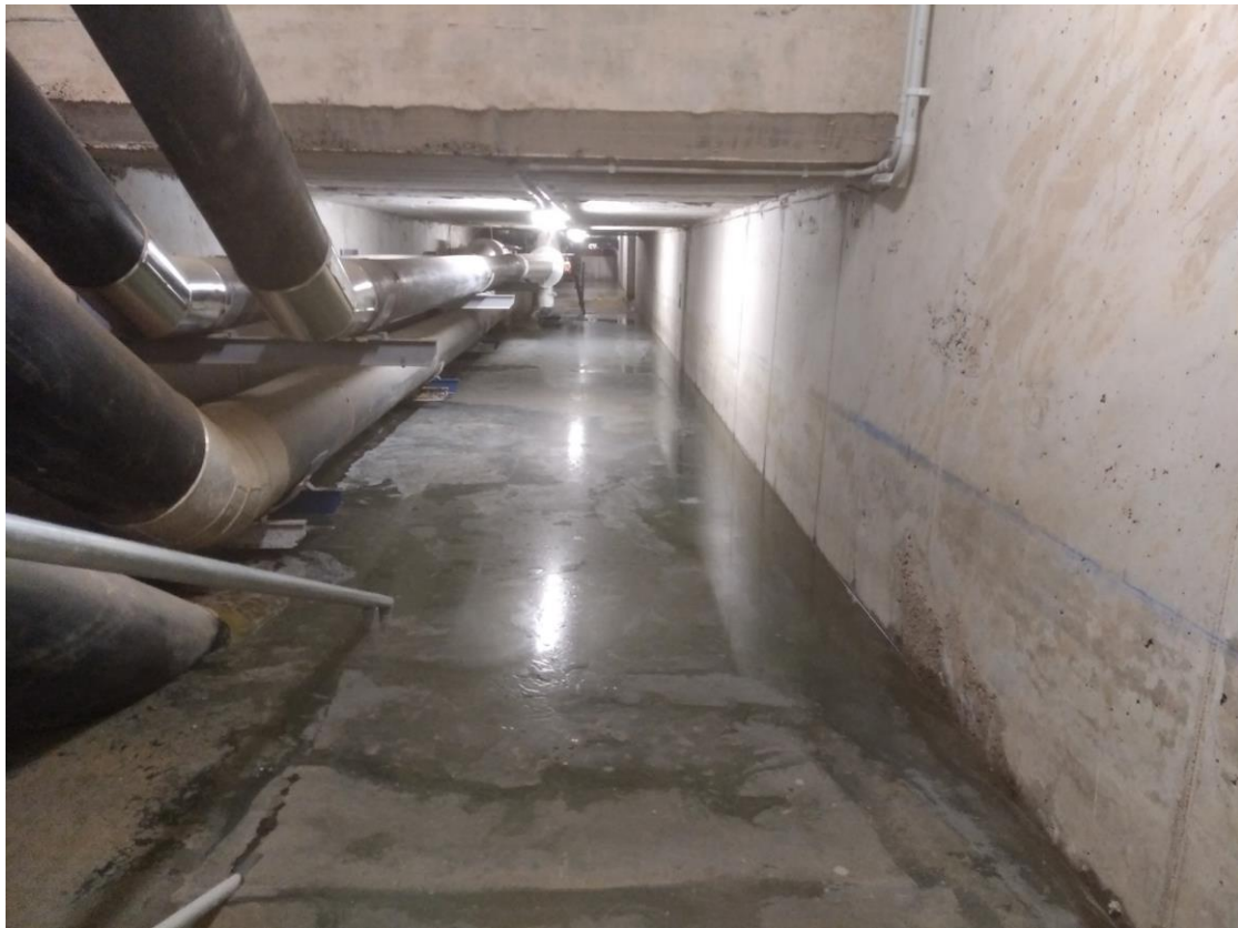
Galeria de Serveis 28. Vista general de la galeria.
