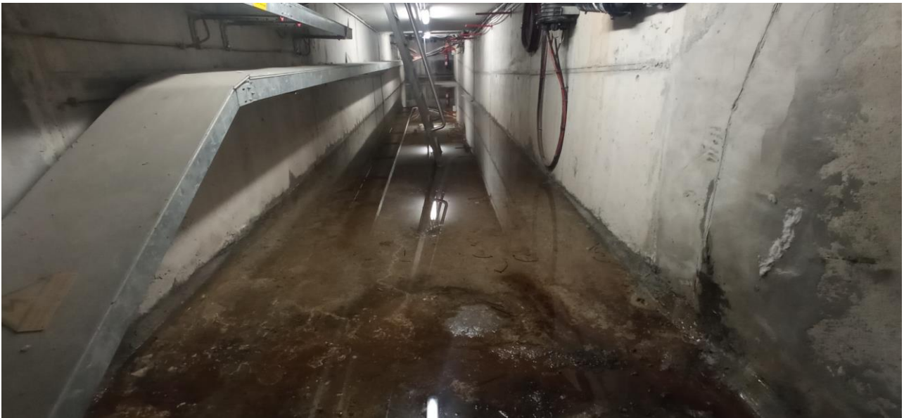
Galeria de Serveis 34. Vista general de la galeria.
