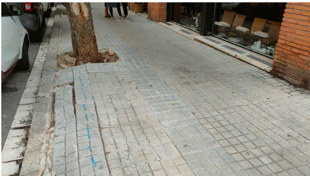
▲ Paviment irregular i deteriorat a l'entorn dels arbres, que no tenen contenció lateral
