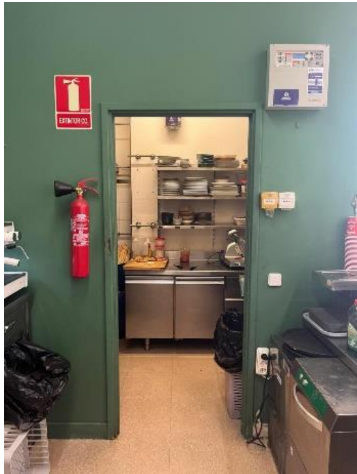
Zona cuina, vista accés.
