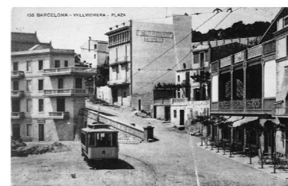
Tramvia de Vallvidrera, plaça de Vallvidrera, cap al 1915 (Font: Institut cartogràfic de Catalunya)
