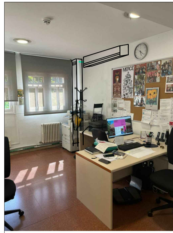
Distribució frigorífica puja a nivell de sostre per a distribuir-se cap a unitat interior, dins de caixa de pladur. Conduïte de ventilació es condueix per caixa de pladur desde planta semisoterrani i s'emboca a reixa.
