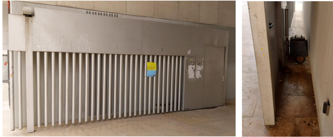
Barana de l'entrada (esquerra) amb òxids, s'ha de rascar i repintar. GRAU 1
